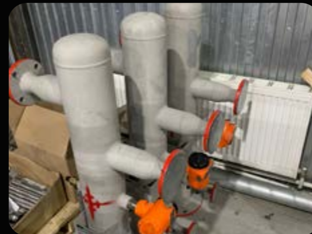
СЕПАРАТОР СЦВ-159-16 с сигнализатором уровня и уровнемерной линейкой по заказу ООО «ИНГК-ПРОМТЕХ»
